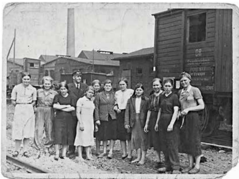
Железнодорожные работы. Дрезден, 1942
